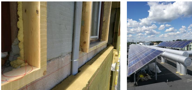
Joonis 25. Välisseina soojustuses asuv ventilatsioonitorustik ja puitraamid akende soojustuse tasapinda tõstmiseks (vasakul) ning PV-paneeleid (paremal).
