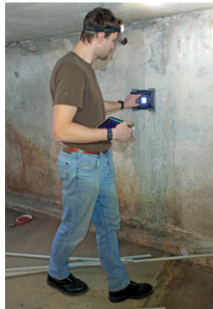
Akadeemia tee 6 keldriseina siseplaadi paksuse mõõtmine maaradariga GP8000 enne tehase renoveerimist.
