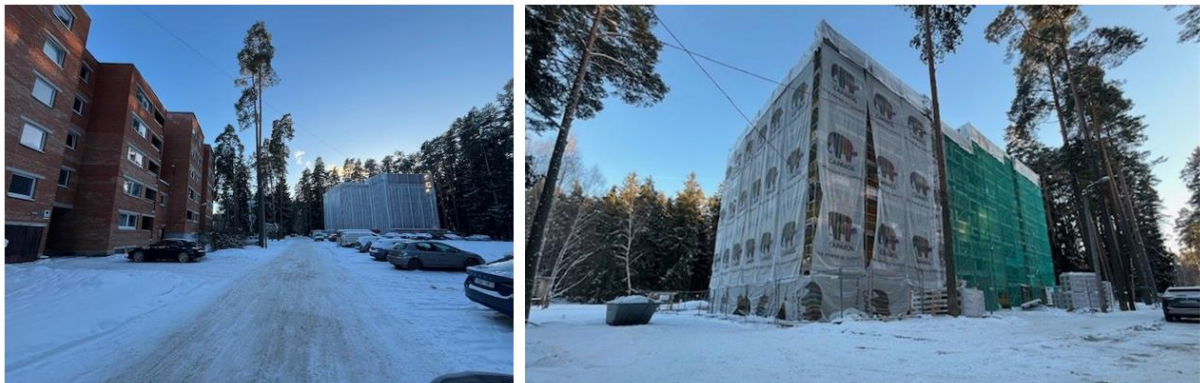
Foto 2 Nooruse 6 ja 7 hoonete rekonstrueerimine 2025 aastal
