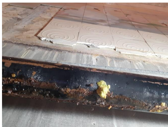
Torustiku väline korrosioon. Kaitsekiht on hajustunud. Torustik aastast 1987.
