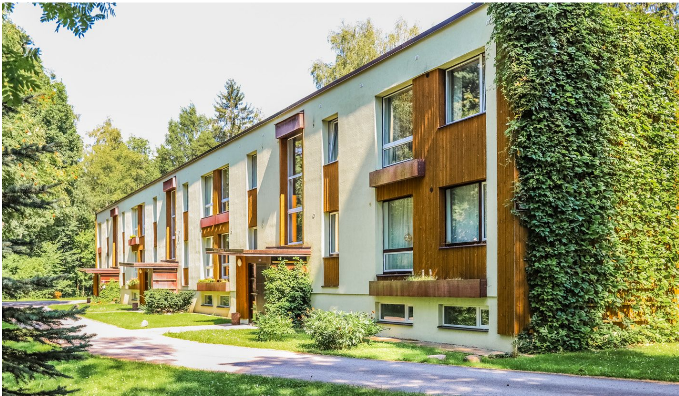
Renoveerimisprojekt Enn Laansoo, foto R.Vähi
